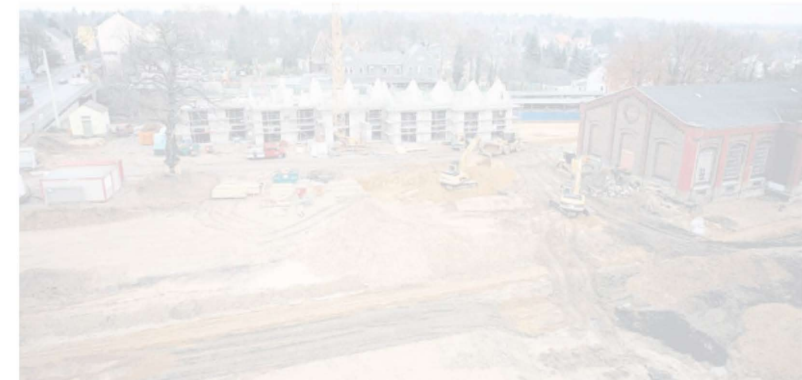
Aus luftiger Höhe erschließt sich, wie viel Boden der Bauverein auf dem Gelände der historischen Pumpstation hat umschaufeln lassen. Die Rohbauten der ersten zehn Häuser sind bald fertig. Vor dem Denkmal werden gerade die Baugruben für den zweiten Bauabschnitt ausgehoben. RP-FOTO: OLAF STASCHIK
